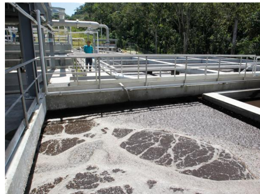
Foto 1. Planta de Tratamiento de Aguas Residuales de Cueros Vélez. Guillermo Ossa / EL TIEMPO. 2017
